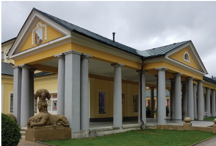
Rysunek 5. Františkovy Lázně, Nowa Pijalnia w centrum uzdrowiska, przy deptaku (fot. E. Gonda-Soroczyńska, październik 2016) Figure 5. Františkovy Lázně, (Franzensbad), New Pump-Room, in the spa and health resort centre, at the pedestrian precinct (photo by E. Gonda-Soroczyńska, October 2016)
