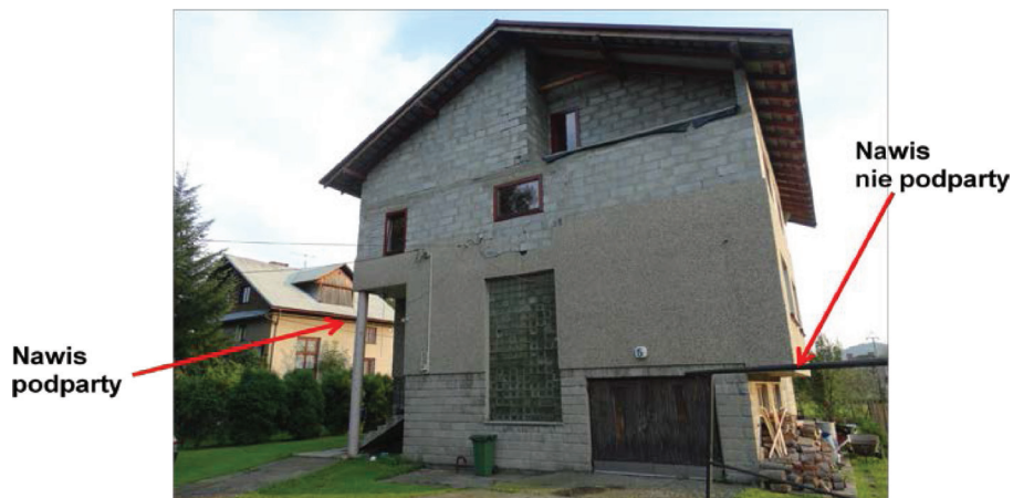
Rysunek 3. Budynek z dwoma nawisami, jeden z nich podparty filarem (autor: Małgorzata Buško)
