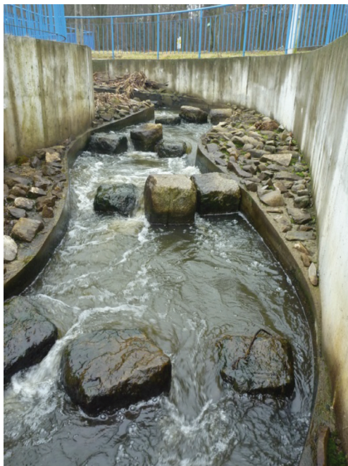
Rysunek 1. Przepławka ryglowa przy zbiorniku Kamionka, rzeka Tuszymka. Figure 1. Rock ramp fishway, Kamionka reservoir, Tuszymka river.
