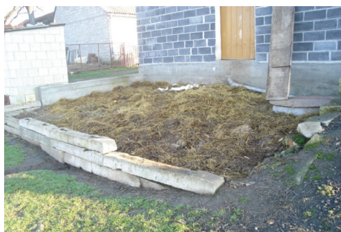
Fotografia 2. Odgrodzenie przymy obornika podkładami żelbetowymi Photo 2. Separation of the dunghill by reinforced concrete ground beam
