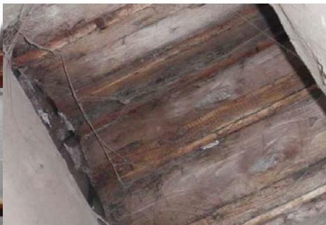
Rysunek 10. Stropodach stajni: a) zawilgocenia na krokwiach, b) zawilgocenia i pajęczyny na daszku wywietrznika
