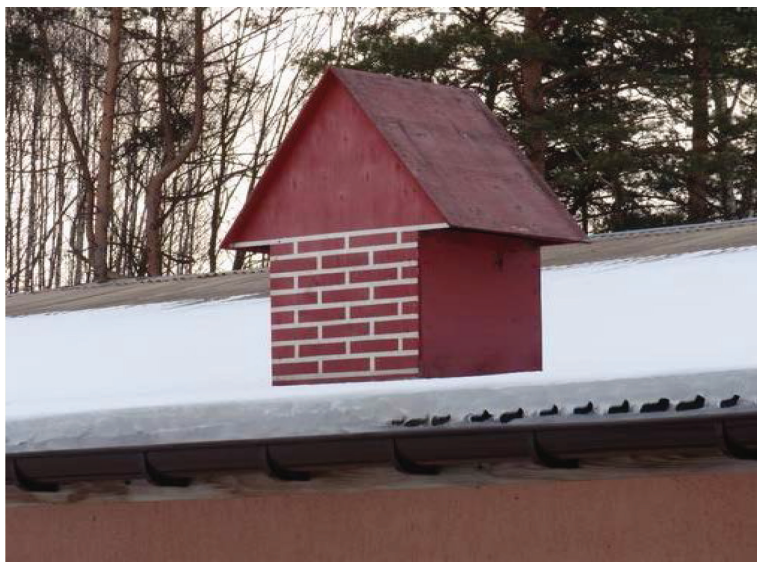
Rysunek 8. Usytuowanie wywietrznika dachowego na dachu stajni Figure 8. The location of the roof vent on the stable roof
