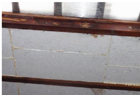
Rysunek 10. Stropodach stajni: a) zawilgocenia na krokwiach, b) zawilgocenia i pajęczyny na daszku wywietrznika
