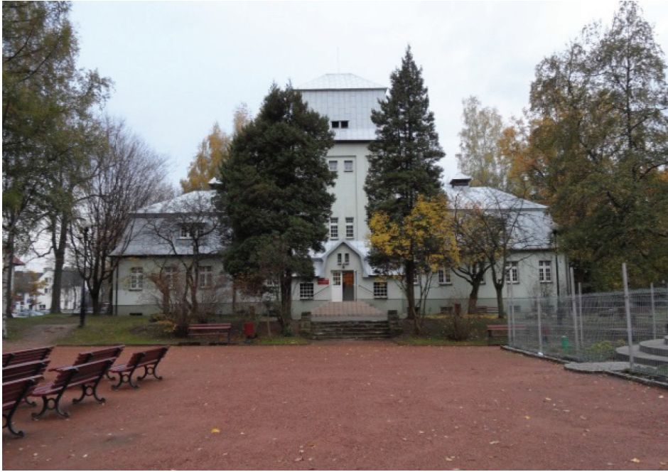
Fotografia 6. Łazienki II (1912 r.) usytuowane naprzeciw Domu Zdrojowego – obecnie Miejski Ośrodek Kultury, Galeria Historii Miasta (fot. autorki, listopad 2012 r.)
