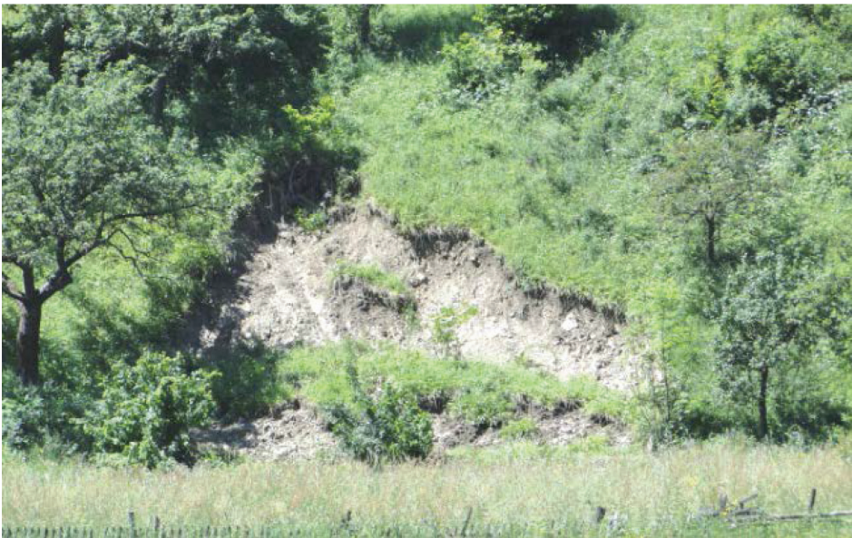
Rysunek 1. Lokalizacja i widok ogólny analizowanych osuwisk Figure 1. Location and general view of the analyzed landslides
