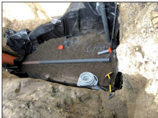
Fotografia 12. Układanie drenu zbierającego ścieki oczyszczone Photo 12. Installation of treated sewage collection drain
