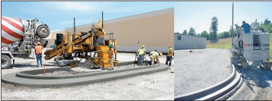
Rysunek 1. Maszyny układające krawężniki [ http://www.gomaco.com , http://heg.baumpub.com ]
