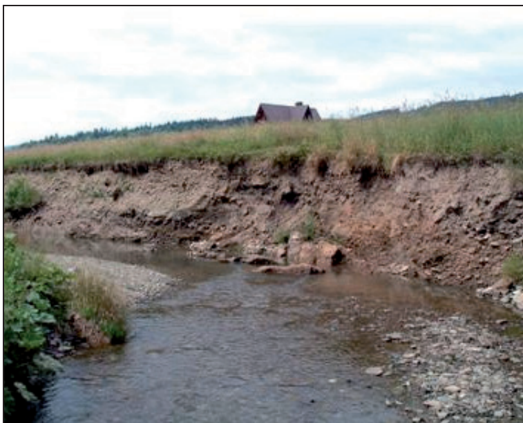
Fotografia 4.4. Bloki gruntowe zdeponowane u stopy skarpy w pobliżu przekroju 2–2 Photo 4.4. Block of soil near the cross-section No 2-2
