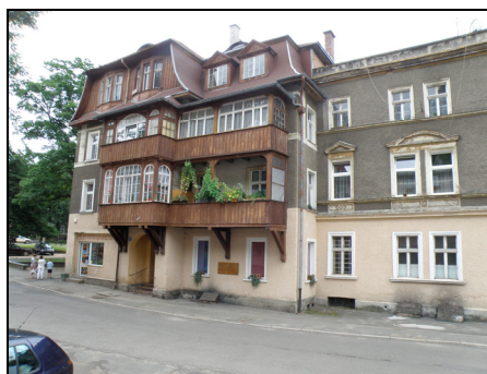
Fotografia 14. Były pensjonat dla kuracjuszy, miejsce zamieszkania Krzysztofa Kieślowskiego, obecnie budynek wielorodzinny (fot. E. Gonda-Soroczyńska) Picture 14. Former lodging house for patients, Krzysztof Kieślowski's residence, now multi-family building (pict. by E. Gonda-Soroczyńska)
