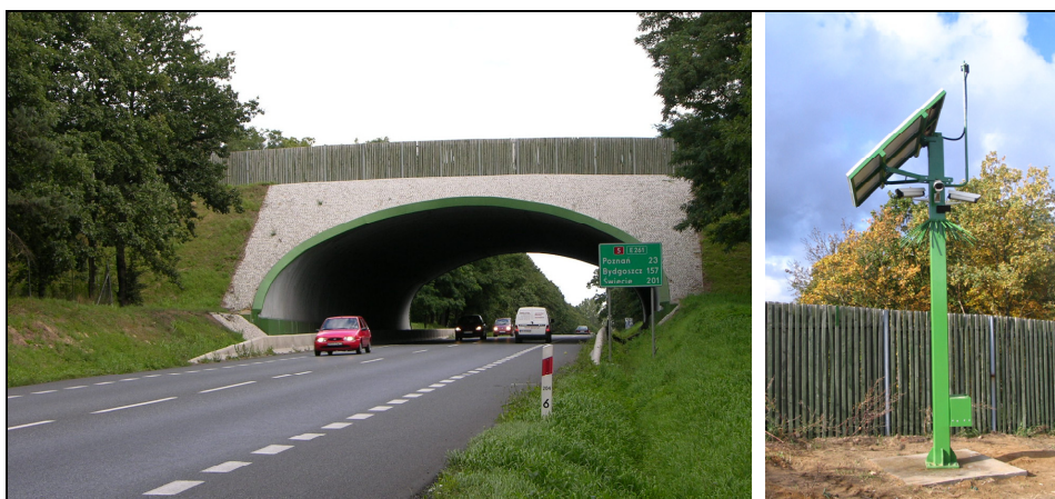
Fotografia 1. Przejście dla zwierząt nad drogą krajową nr 5 oraz zestaw obserwacyjny wraz z układem zasilającym (fot. M. Górna)
