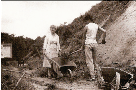
Rysunek 13. Prace renowacyjne przy Kopcu 1987 r. [Bukowski, 2002] Figure 13. 1987, renovation of the Mound [Bukowski, 2002]
