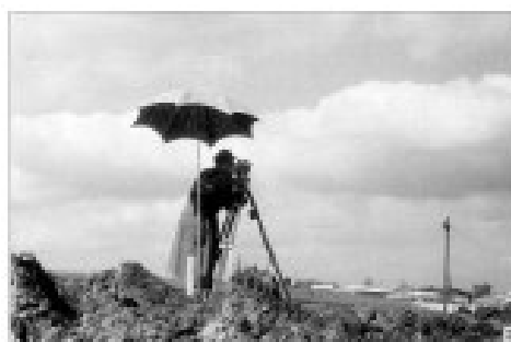
Rysunek 22. Lwów: A, B, C, D – prace przy pomiarze bazy drutami irwanowymi i sieci triangulacyjnej miasta Lwowa. (A – z opaską na rękawie prof. Władysław Wójcicki 1932 r. Fot. I. Rabczuk)
