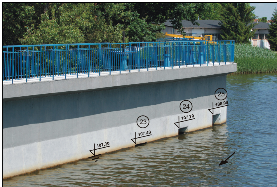
Fotografia 1. Wloty do przepławki od wody górnej (komory nr 25, 24, 23) (fot. M. Mokwa)
