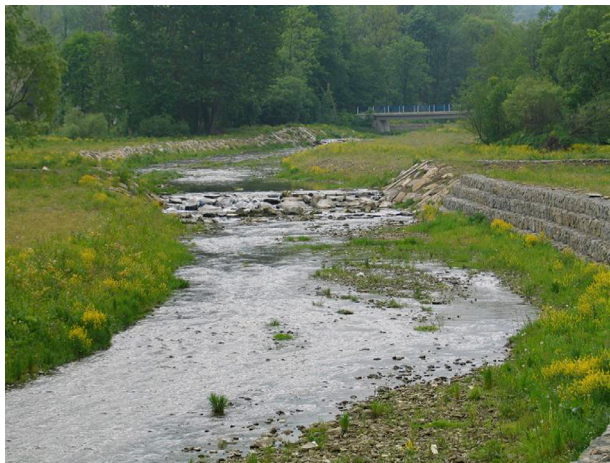
Fotografia 12. Bystrze na potoku Jachówka-Bieńkówka. Zwróć uwagę na odtwarzające się łachy korytowe powyżej górnego i poniżej dolnego stanowiska budowli. Łachy te stanowią o bogactwie fauny rzecznej oraz tworzą element roztekowania w uregulowanym korycie (patrz tekst oraz Radecki-Pawlik 2006a) (fot. A. Radecki-Pawlik)
