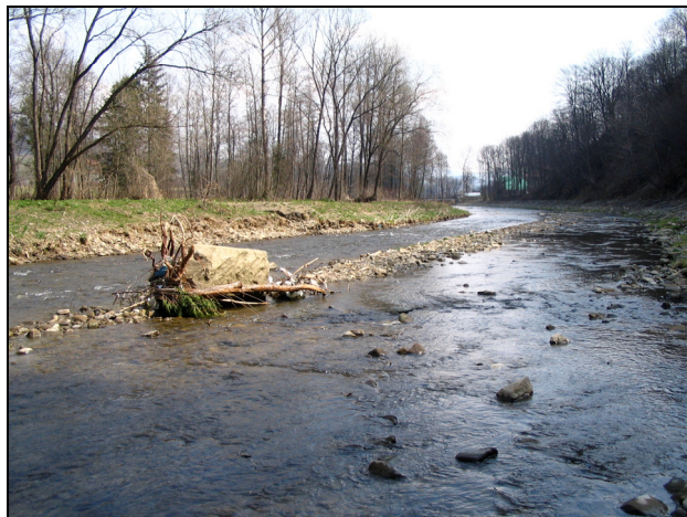
Fotografia 24. Ziarno ponadwymiarowe na dnie koryta potoku pozostawione celowo przy regulacji koryta rzeczno. Zwróć uwagę na łacę korytową odtwarzającą się poniżej ziarna (fot. A. Radecki-Pawlik)
