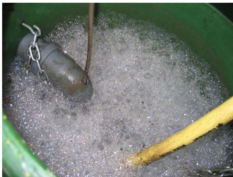
Rysunek 31. Widok piany w komorze napowietrzania powstałej w trakcie badań modelowych [fot. A. Wałęga]
