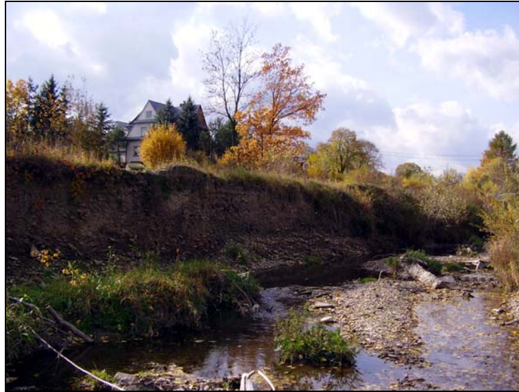
Rysunek 2. Erozja prawego brzegu – odcinek pomiarowy 1 Figure 2. Erosion of the right bank – measuring sector 1
