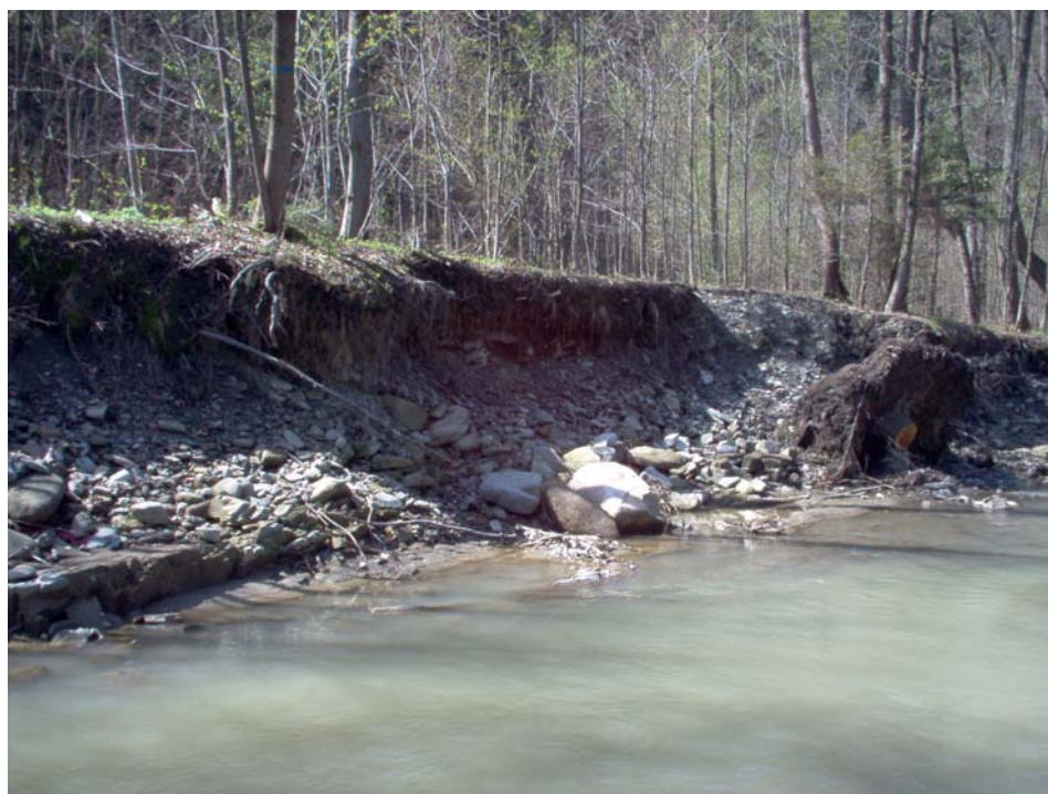
Rysunek 2. Wcięcie potoku w brzeg poniżej zapory przeciwrumowiskowej
