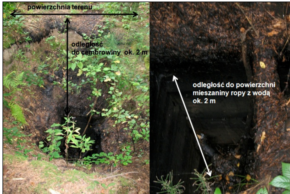
Rysunek 3. Studnia kopana z ropą naftową, z zachowaną cembrowiną, Wara, Województwo Podkarpackie [Lipińska 2009]
