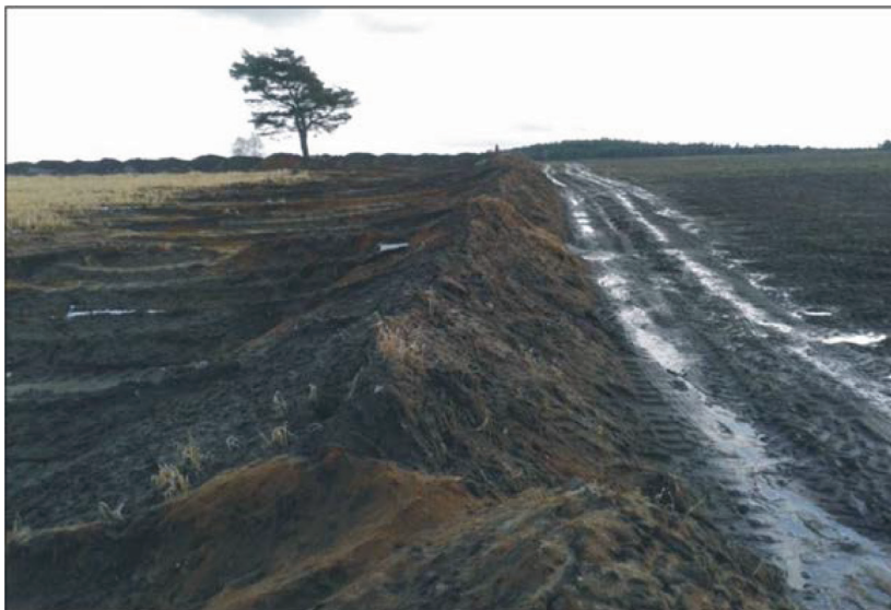
Fotografia 2. Sołectwo Ostrowite; pierwszy etap przygotowywania terenu do eksploatacji: zdejmowanie i zwałowanie warstwy próchnicznej gleby (fot. A. Fiszka Borzyszkowska; 28 września 2014)
