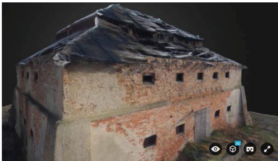
Rysunek 11. Spichlerz w Grzeczynie (Zachodniopomorskie) opracowany na podstawie zdjęć z kamery GoPro zamontowanej na UAS, źródło: Antosik A., opublikowano na: https://sketchfab.com/models/7ccd952548364e0fa599022fe80669fd (dostęp na dzień 1.04.2016r).
