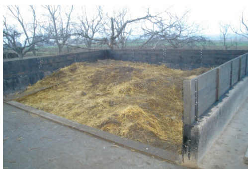
Fotografia 2. Odgrodzenie przemy obornika podkładami żelbetowymi Photo 2. Separation of the dunghill by reinforced concrete ground beam
