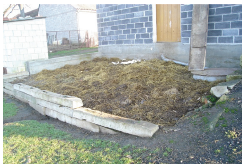
Fotografia 2. Odgrodzenie przemy obornika podkładami żelbetowymi Photo 2. Separation of the dunghill by reinforced concrete ground beam
