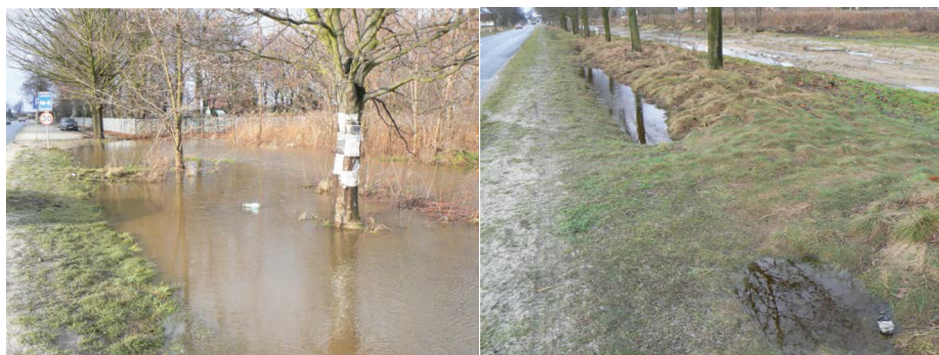
Rysunek 5 i 6. Miłoszyce gm. Jelcz-Laskowice. Podtopienia będące skutkiem niedrożnych rowów melioracyjnych i bądź ich zniszczenia. Fot. W. Jabłoński Figure 5 and 6. Miłoszyce municipal Jelcz-Laskowice. Flooding resulting from clogged ditches and or their destruction.
