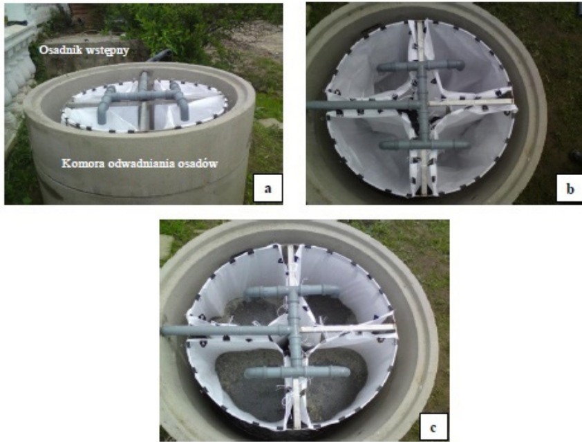
a – widok z boku, b – widok z góry (przed napełnieniem worków osadem), c – widok z góry (po napełnieniu worków osadem) a – side view, b – view from the top (before filling the bags of sediment) c – view from the top (after filling the bags of sediment)
