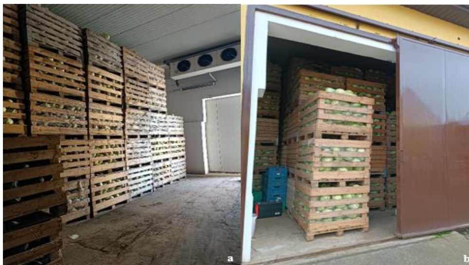
Rysunek 4. Przechowalnia w Biórkowie Małym (IV): (a) wewnątrz (b) zewnątrz [Źródło: fot. własne]
