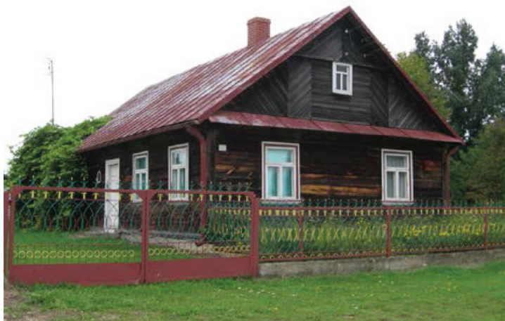
Rysunek 5. Drewniany drugi dom w gminie Hajnówka (fot. A. Gawryluk) Figure 5. Wooden second house in Hajnowka district (photo A. Gawryluk)
