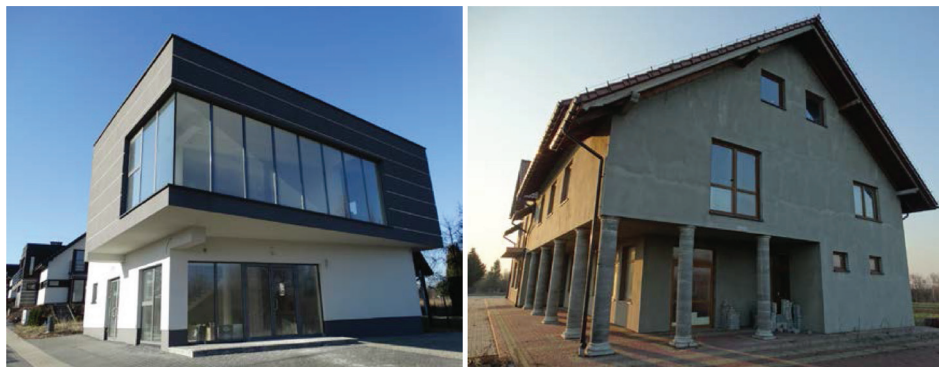
Rysunek 4. Przykłady budynków z nawisem bez filarów i nawisem podpartym filarami (autor: Małgorzata Buško)
