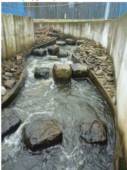
Rysunek 1. Przepławka ryglowa przy zbiorniku Kamionka, rzeka Tuszymka. Figure 1. Rock ramp fishway, Kamionka reservoir, Tuszymka river.
