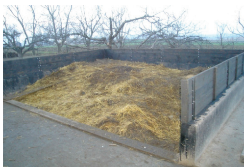
Fotografia 2. Odgrodzenie przyzmy obornika podkładami żelbetowymi Photo 2. Separation of the dunghill by reinforced concrete ground beam
