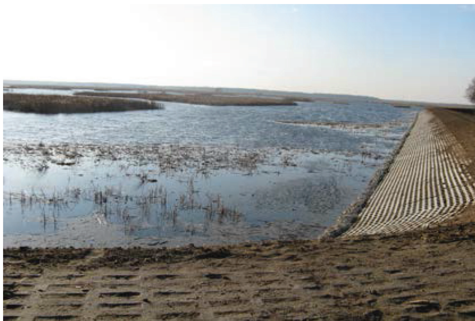
Fotografia 13. Odbudowa I-go etapu zbiornika wodnego Mosty o objętości 6,8 mln m 3 przekazanego do użytkowania w 2011 r.
