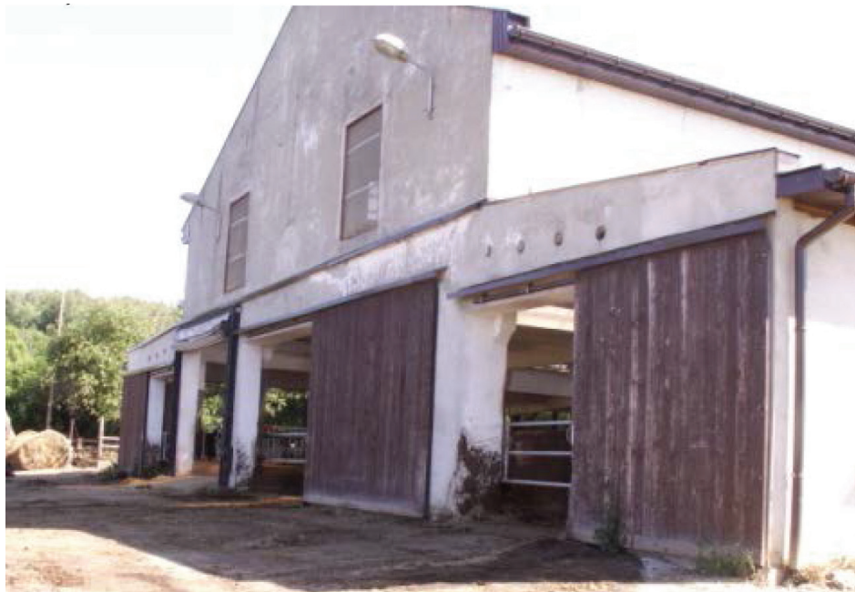
Fotografia 2. Elementy systemu wentylacyjnego a) kurtyny na ścianie północnej, b) kurtyny na ścianie południowej, c) wrota na ścianie zachodniej
