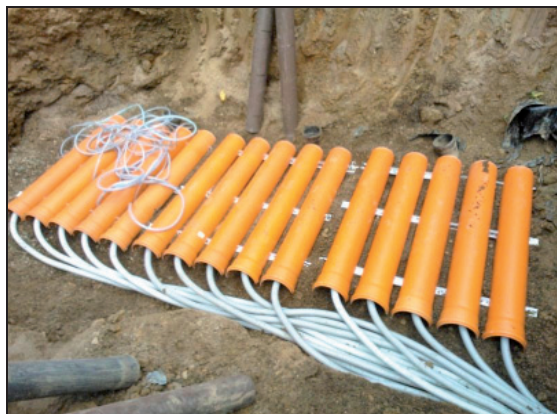
Fotografia 14. Układ rozpraszający ścieki po powierzchni zmodyfikowanego złoża żwirowo-piaskowego „F1”
