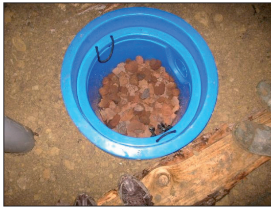
Fotografia 10. Kosz wypełniony puzzolaną instalowany na odpływie z osadnika Photo 10. Basket filled with pozzolan installed at the outlet from the settling tank
