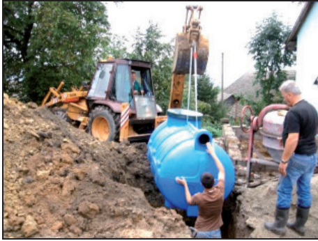
Fotografia 9. Osadnik gnilny - fazy montażu Photo 9. Septic tank - installation stages
