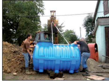
Fotografia 9. Osadnik gnilny - fazy montażu Photo 9. Septic tank - installation stages
