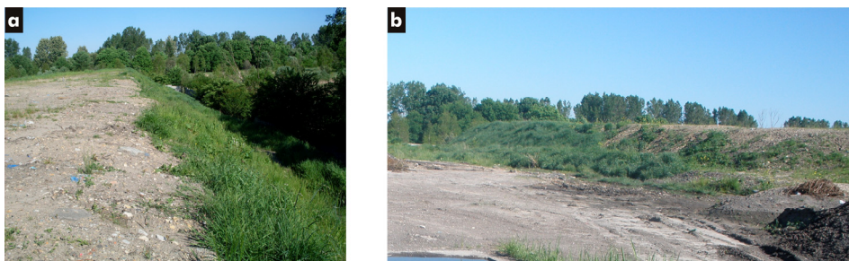
Rysunek 2a, b. Korona i skarpy kwatery II składowiska w Chełmku Figure 2a, b. Crest and slopes of the quarter II of municipal waste dumping site in Chełmek
