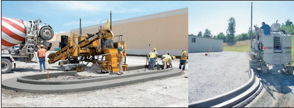
Rysunek 1. Maszyny układające krawężniki [ http://www.gomaco.com , http://heg.baumpub.com ]
