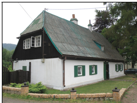
Fot. 11. Budynek mieszkalny przy ulicy Głównej 1 z 1763 r. (fot. Anna Soroczyńska) Picture 11. Dwelling-house at 1 Main Street of 1763 (pict. by Anna Soroczyńska)
