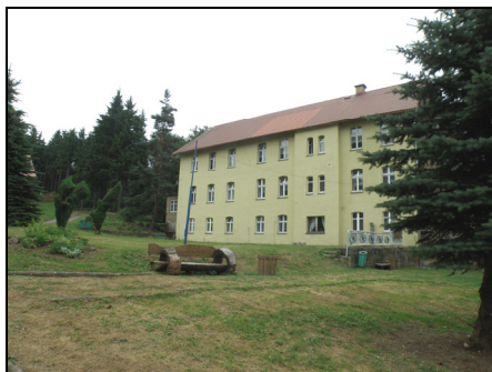
Fot. 12. Wojewódzki Specjalistyczny ZOZ Chorób Płuc, dawny Budynek „Odrodzenie” (fot. E. Gonda-Soroczyńska) Picture 12. Provincial Specialist Pulmonology Health Care Centre, now “Odrodzenie” building (pict. by E. Gonda-Soroczyńska)
