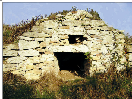
Rysunek 13. Piwnice z otworami wentylacyjnymi. Figure 13. Cellars front walls with ventilating hole. Fot. 2010
