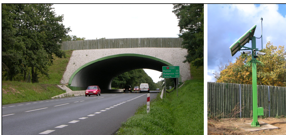
Fotografia 1. Przejście dla zwierząt nad drogą krajową nr 5 oraz zestaw obserwacyjny wraz z układem zasilającym (fot. M. Górna)
