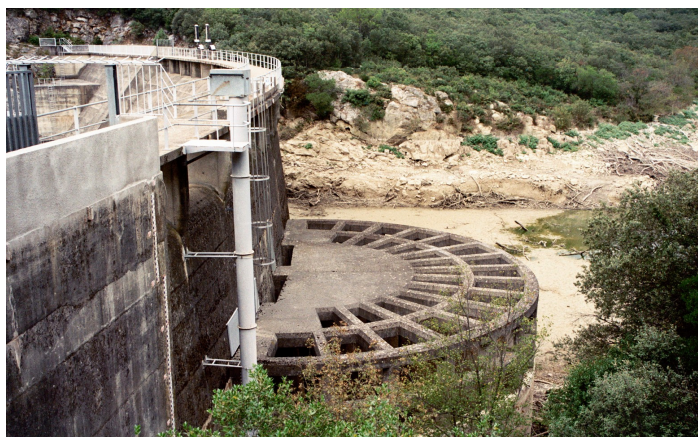
Fotografia 4. Zapora la Rouvière: zapora wstępna stwarzająca stały zbiornik oraz kraty betonowe
