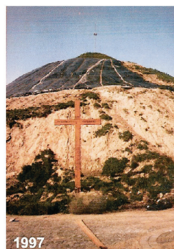
Rysunek 16. Zniszczenia Kopca przez katastroficzne deszcze. Rok 1997 [Bukowski, 2002] Figure 16. 1997, the Mound eroded by catastrophic rains [Bukowski, 2002]
