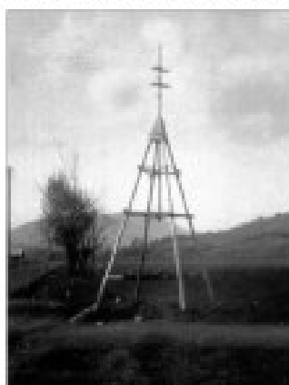
Rysunek 18. Okolice Lwowa. Praktyka geodezyjna. Sygnał triangulacyjny w krajobrazie naturalnym. 1932 r. Fot. I. Raibczuk
