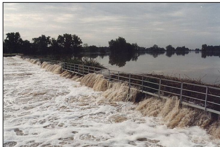
Rysunek 4. Roślinność zmniejszająca wydatek przeważu na wlocie do kanału Odra-Widawa (fot. H. Orzeszyna) Figure 4. Vegetation reducing the discharge of the inlet weir to channel Odra-Widawa (photo H. Orzeszyna)
