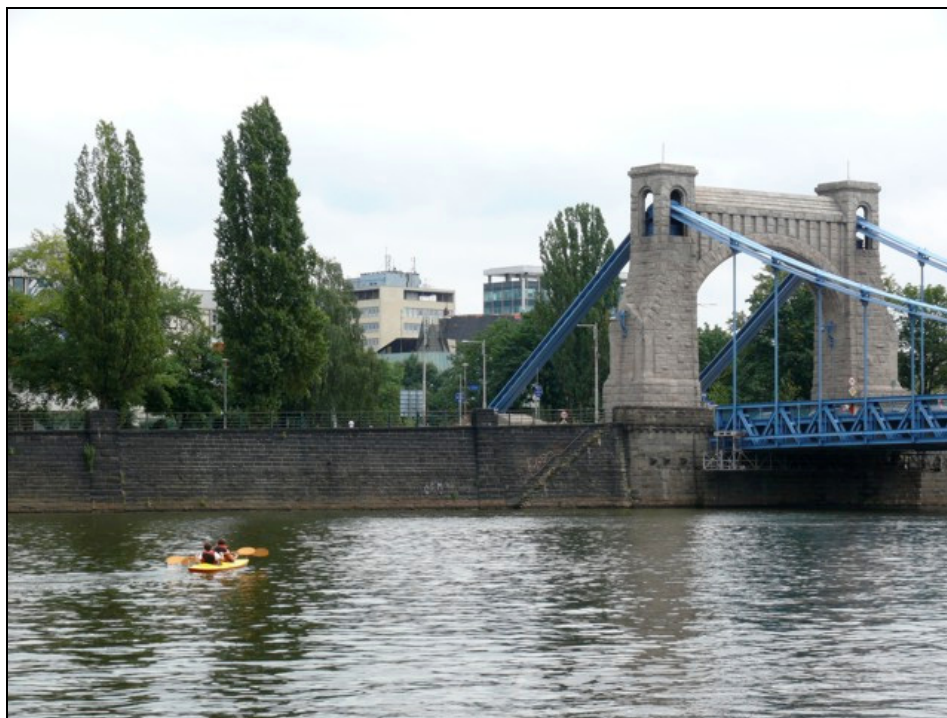
Fotografia 5. Umocnienia prawego brzegu rzeki Odry poniżej mostu Grunwaldzkiego we Wrocławiu (zdjęcie autorów, czerwiec 2008 r.)
