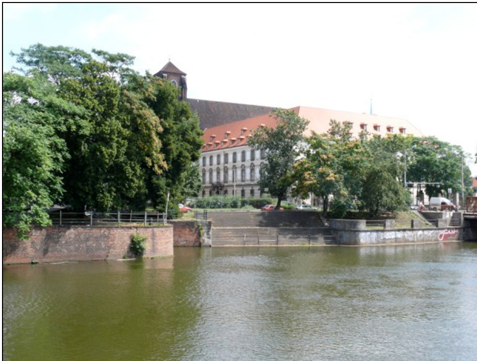
Fotografia 6. Fragment nabrzeża południowego Wyspy Piaskowej we Wrocławiu (zdjęcie autorów, czerwiec 2008 r.)
