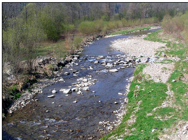
Fotografia 13. Bystrze na potoku Krzczonowskim. Zwróć uwagę na pozornie bezładnie ułożony kamień łamany, spełniający rolę zabezpieczenia miejscowego dna. W dnie ułożone jest przejście rurami wodociągowymi (fot. A. Radecki-Pawlik)
