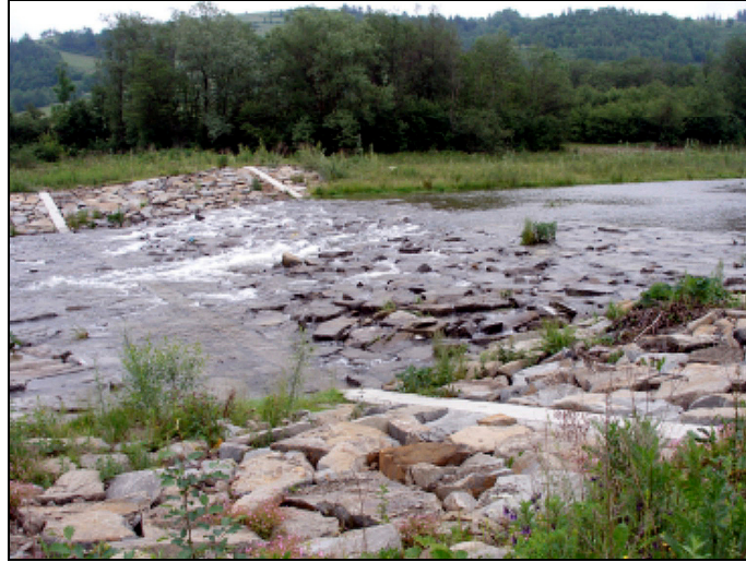
Fotografia 10. Prawidłowo wykonane i działające z zasadami prawidłowego utrzymania koryta rzeczno bystrze na potoku Porębianka. Zwróć uwagę na koncentrację przepływu na płycie spadowej bystrza, zapewniającą migrację ryb nawet przy niskich stanach wody (fot. A. Radecki-Pawlik)
