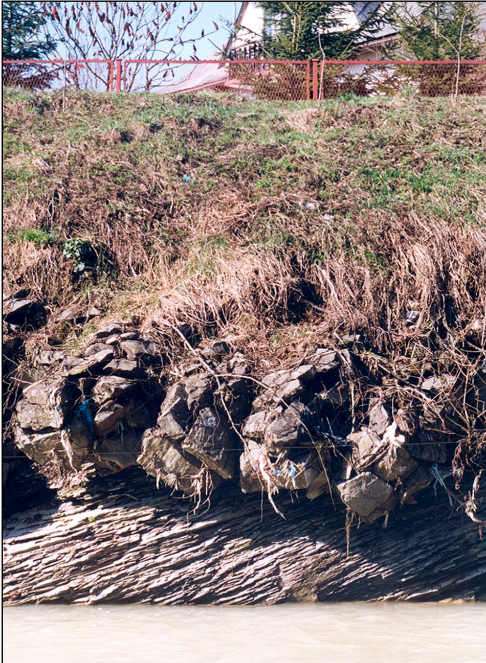
Fotografia 5. „Wiszące” opaski siatkowo-kamiennie w korycie rzeki Mszanki (fot. J. Korpak) Photography 5. Bank reinforcements, suspended above the water surface, the Mszanka River channel (photo of J. Korpak)
