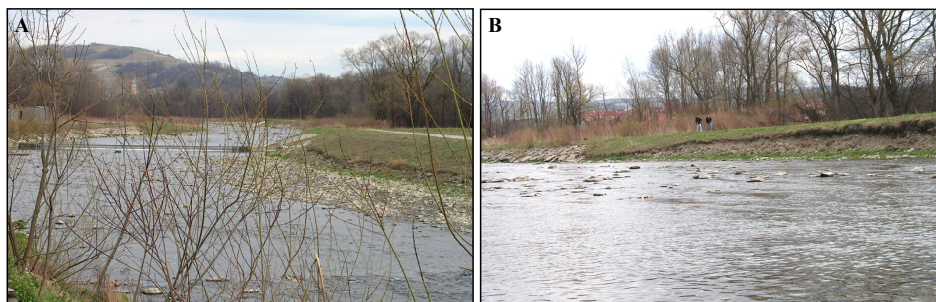
Fotografia 9. „Niedopasowanie” korekcyjnej stopniowej w korycie Mszanki do reżimu hydrologicznego rzeki: A – powstawanie łach bocznych zwężających przekrój koryta podczas niskich stanów wody, B – erodowanie brzegów przez niemieszczącą się w korycie wodę podczas wezbrań
