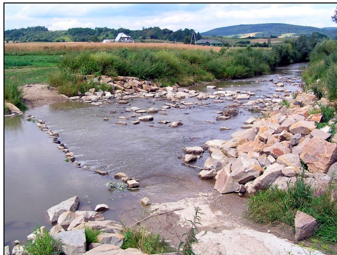
Fotografia 11. Bystrze na potoku Sanoczek. Zwróć uwagę na pozornie bezładnie ułożony kamień łamany, spełniający rolę redukcji spadku dna cieku (fot. A. Radecki-Pawlik)
