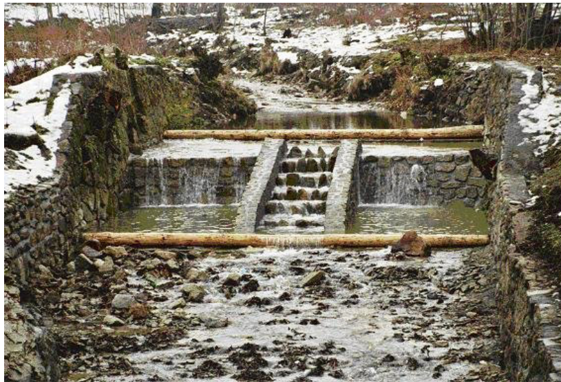
Fotografia 2. Przepławka ryglowa, widok od wody dolnej, Czarny Potok (autor Niesobski) Photography 2. The half-timbered fish passed, view from downstream water stage, stream Czarny Potok (author Niesobski)
