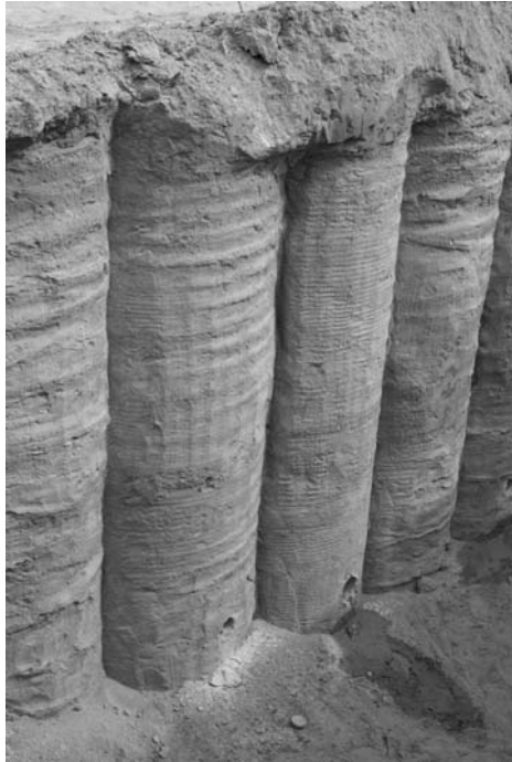
Fotografia 1. Widok odsłoniętej przegrody przeciwfiltracyjnej z pionowych pali wykonanych metodą głębokiego mieszania Photo 1. View of slurry wall uncover built by deep soil mixing method
