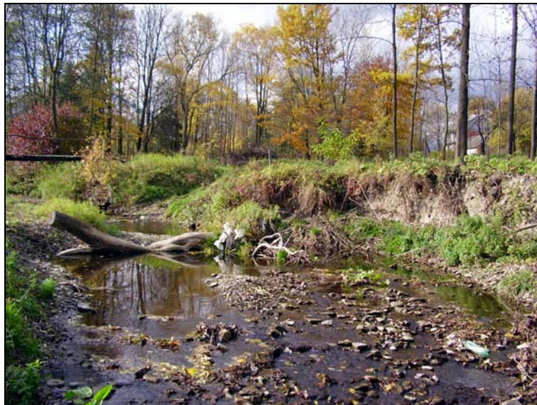
Rysunek 5. Erozja lewego brzegu – odcinek pomiarowy 2 Figure 5. Erosion of the left bank – measuring sector 2
