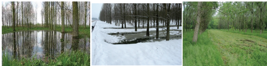
Rysunek 1. Oczyszczalnia roślinno-glebowa w Brzeźnie Figure 1. Sewage treatment plant and soil in Brzeźno
