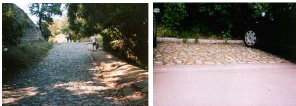
Rysunek 3. Przykłady nawierzchni przepuszczalnych wykonanych z kamienia polnego
