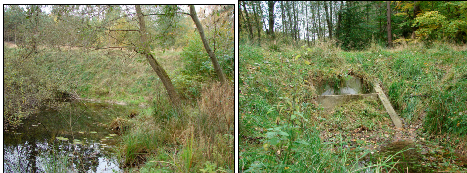
Rysunek 3. Korpus drogi pełniący funkcję grobli i przepusto-zastawka typu PP1/60 (fot. I. Tereszczak)
